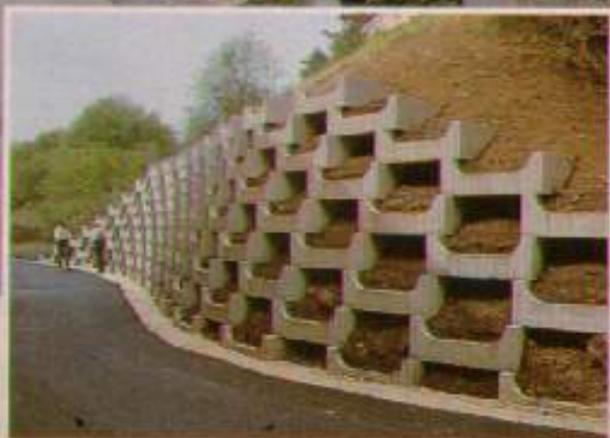
Eine Hangsicherung aus RemuTex-Elementen: kleines Bild: unmittelbar nach Fertigstellung – großes Bild: nach soeben erfolgter Bepflanzung. Die Abbildungen veranschaulichen gut den großen Raum, der für die Bepflanzung zur Verfügung steht und der auch für Sträucher oder größere Pflanzen Platz bietet.
